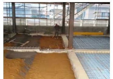
工事中的様子
